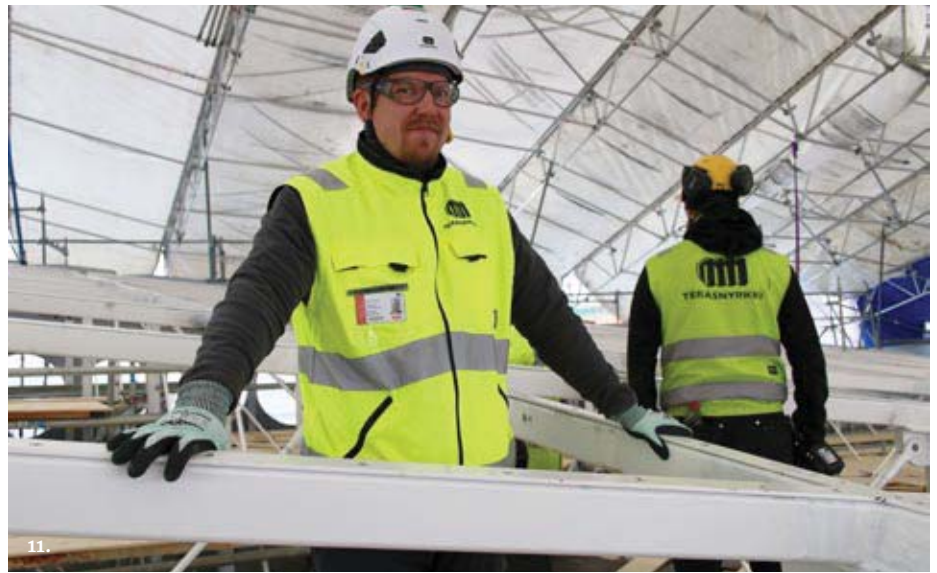
Kuva 11: Teräsnyrkki Steelin toimitusjohtaja Ville Punnonen tutkaillee yhtiön valmistamia Kaikukatu 5:n lasikaton teräsrakenteita. Lasien asennus teräsrungon päälle kuuluu myös Teräsnyrkin urakkaan. Varsinaisen tukirakenteen päälle on kiinnitetty ruuveilla säädettävät listat, joiden päälle lasit sitten asennetaan niiden vaatimaan toleranssimaailmaan.
